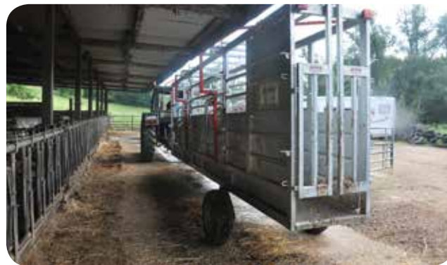
Couloir mobile avec relevage hydraulique.
