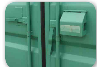
Fermeture par cadenas, protège contre l'effraction
