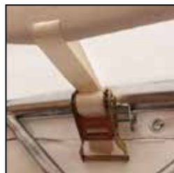
Fixation de la bâche à la structure
