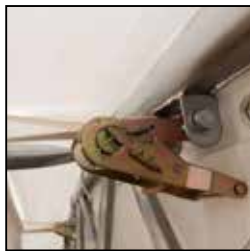
Fixation de la bâche à la structure
