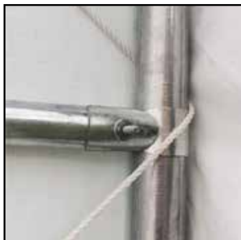
Fixation de la bâche à la structure par cordelettes
