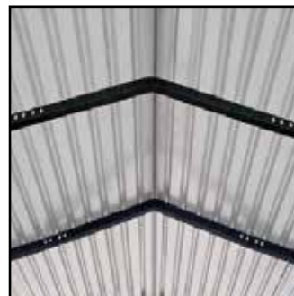
Structure du plafond
