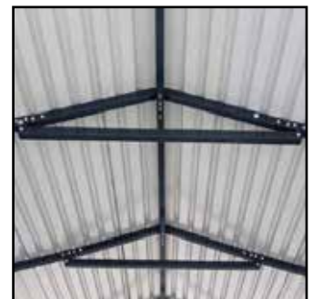
*Structure du plafond avec croisillons (sur modèle ht. 3m78 seulement)
