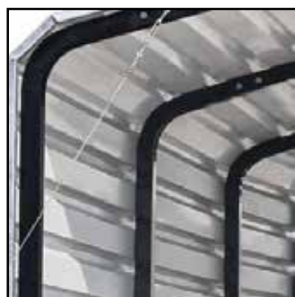
Détail structure latérale et panneaux
