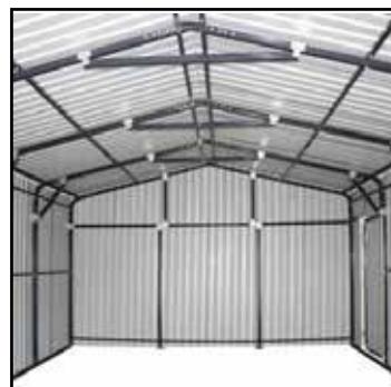
Vue globale de la structure du bâtiment et croisillons
