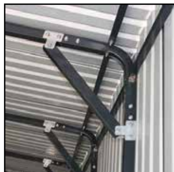
Poutrelles de soutien de la structure
